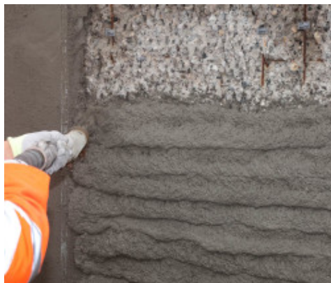
Aplicarea Mapegrout 430 Zero prin pulverizare
