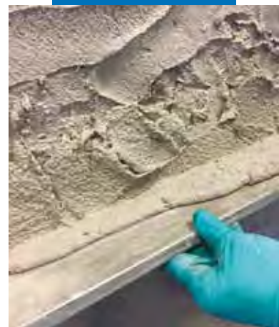
Nivelarea PoroMap Deumidificante cu un dreptar metalic
