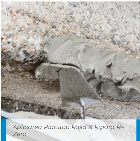
Discuirea suprafeței Planitop Rasa & Ripara R4 Zero
