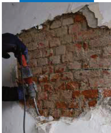
Îndepărtarea tencuiei deteriorate
