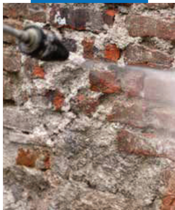
Spălarea cu presiune a zidăriei
