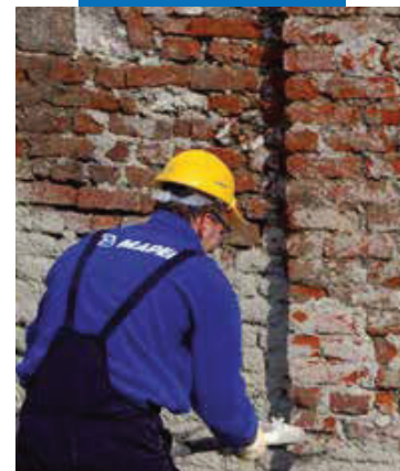
Aplicarea PoroMap Rinzafo Plus cu o masină de tencui
