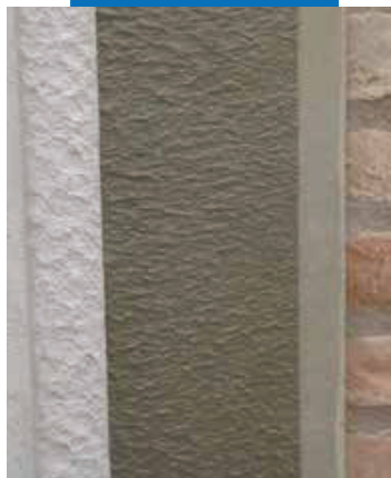
Aplicarea PoroMap Rinzafo Plus pe Mapelastich Foundation pentru crearea unui ciclu anti-condens
