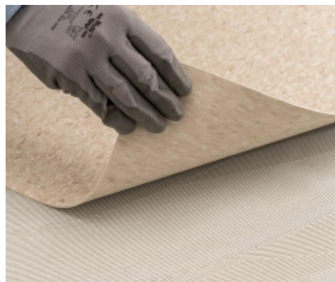
Montarea de PVC omogen cu Ultrabond Eco V4 Evolution ZERO
