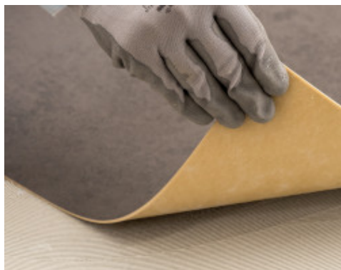
Montarea unei pardoseli pe baza de poliuretan cu Ultrabond Eco V4 Evolution ZERO
