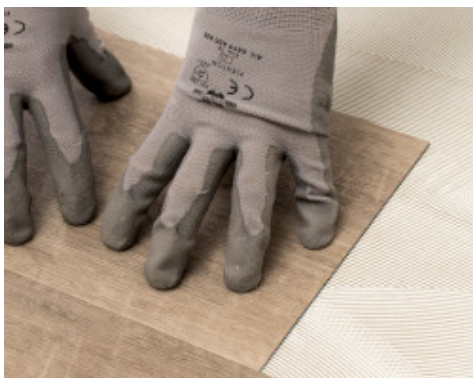
Montarea de LVT cu Ultrabond Eco V4 Evolution ZERO
