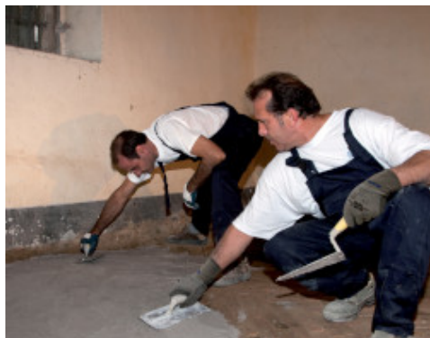
Aplicarea primului strat de Planitop HDM Restauro cu spatula pe extradusul unei bolti
