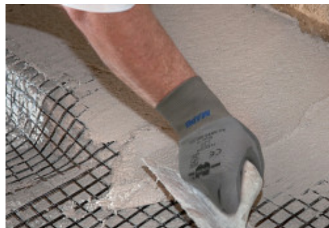
Aplicarea celui de-al doilea strat de Planitop HDM Restauro cu spatula pe extradusul unei bolti pentru a acoperi plasa Mapegrid G 220 cu un strat uniform
