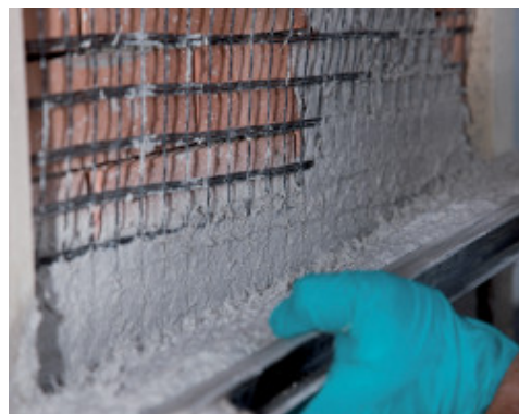
Aplicarea sistemului Planitop HDM Restauro cu Mapegrid G 220 pe un perete din caramida
