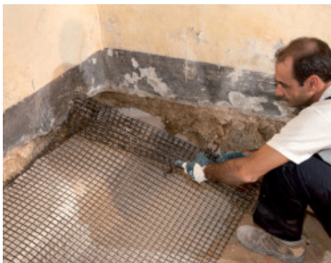
Pozitionarea Mapegrid G 220 plasa de armare din fibra de sticla alcali-rezistenta sh
