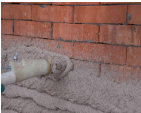
Aplicarea Planitop HDM Restauro prin pulverizare pe un perete din caramida
