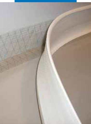
Aplicarea unei plinte din PVC imbracat in plastic utilizand Mapecontact
