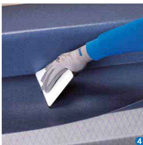
Masarea PVC dupa aplicarea Mapecoat
