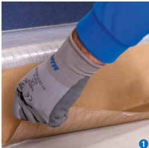
Pozitionarea Mapecoat pe o contratreapta
