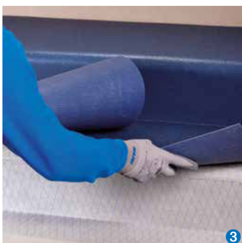
Aplicarea PVC pe trepte utilizand Mapecoat
