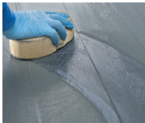
Curatarea si finisarea rosturilor cu buretele din celuloza dura
